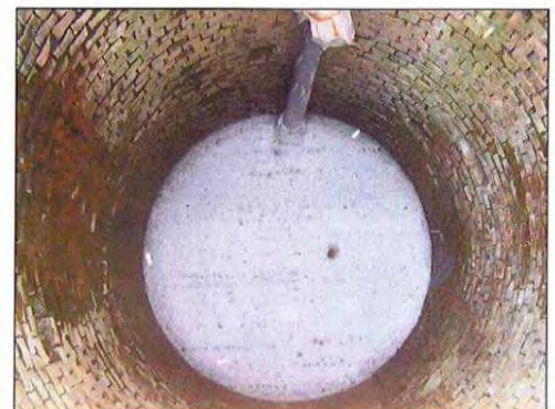
Puits NEUF traité par bouchon autoportant Concession de houille de Sainte-Foy-L'Argentière © GEODERIS
