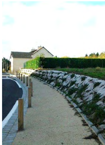
Circulations piétonnes matérialisées en béton désactivé
