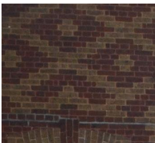
Appareillage ouvragé de la maçonnerie
