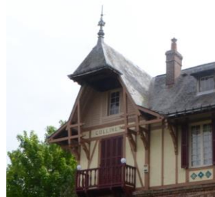
Fronton en charpente apparente
