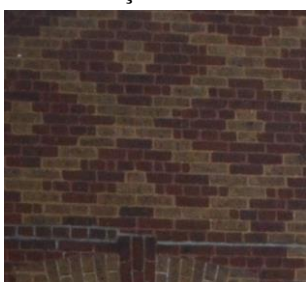
Appareillage ouvragé de la maçonnerie
