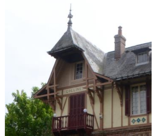
Fronton en charpente apparente
