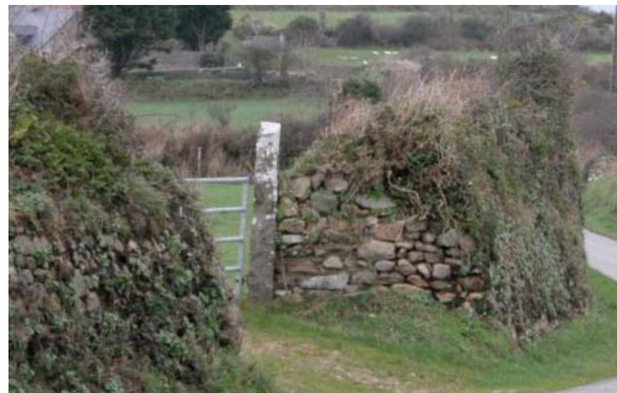
Structure en pierres d'un talus.
