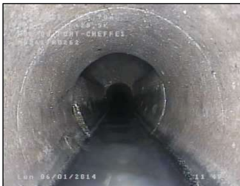
Fissure ouverte circonférentielle
