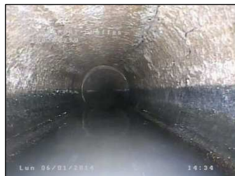
Fissure ouverte longitudinale
