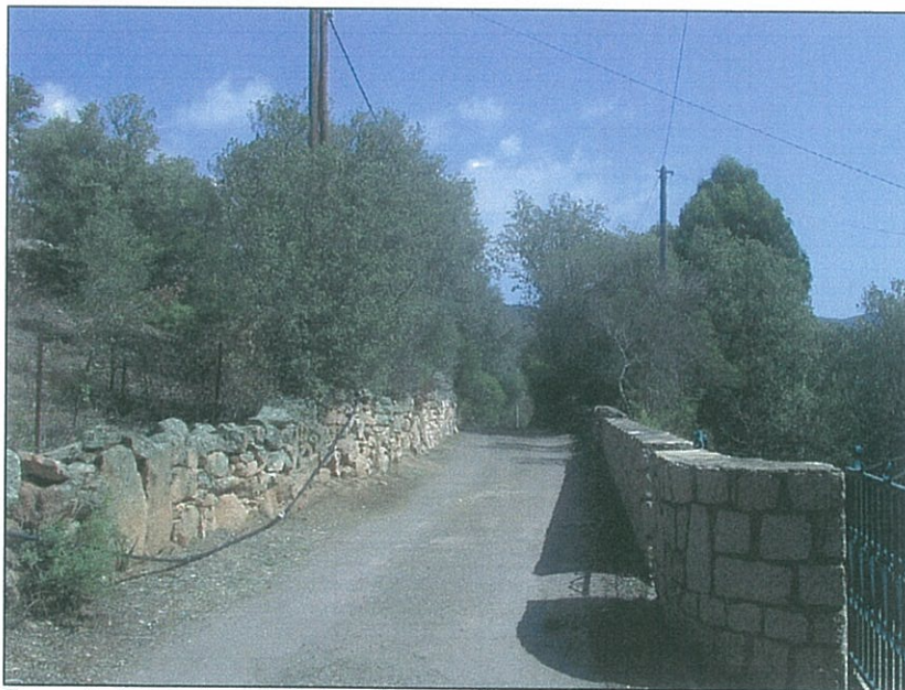
Exemple 1 : anciennes limites de parcelles agricoles maintenues. Re-constitution avec des techniques contemporaines d'un muret aux caractéristiques similaires (granite et hauteur)
