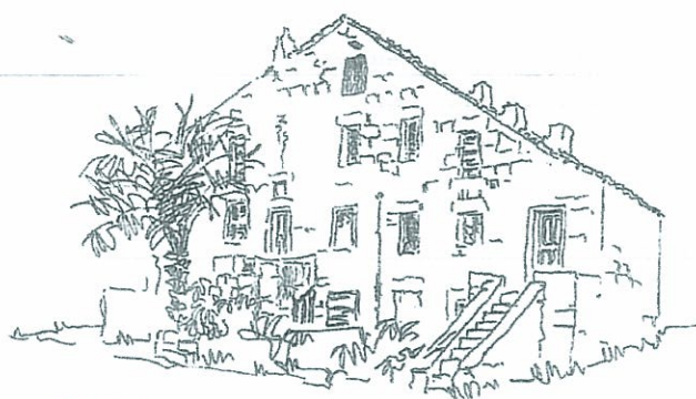
Toit à deux versants faîtage perpendiculaire à la façade principale - Figari
