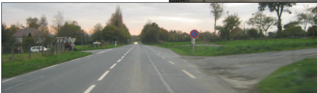
Carrefour de la Barberie (D6) : aménagement de dépassements par la droite sur chaque côté
