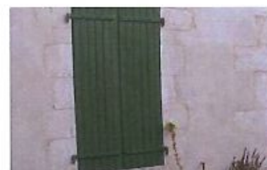
Mur de moellons avec un enduit couvrant
