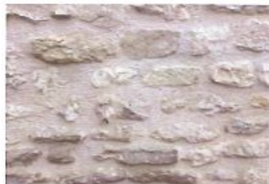
Mur avec un enduit affleurant
