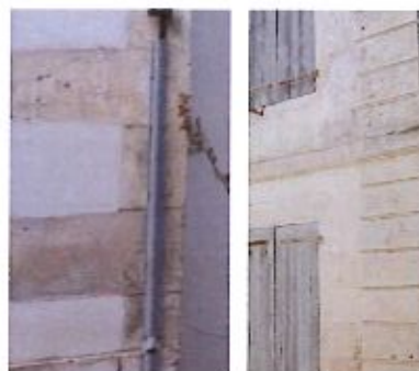
Chaînage d'angle et pilastre
